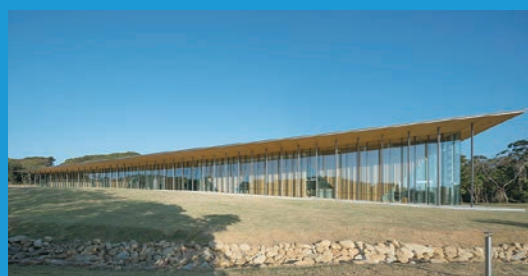
● 国際鯨類施設 令和6年4月に国際鯨類施設が完成しました。施設は、研究室、書籍3万冊と資料を集めた図書室。90人収容できる研修ホールがあり鯨類研究の拠点施設として利用されます。
